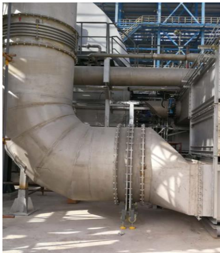
大型Atlas火焰防阻器 D=1200 mm，應用於 RCO系統VOC管道防護；北京燕山石化。
