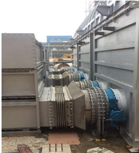
大型Atlas火焰防阻器 D=1200 mm，應用於 RTO系統VOC入口管道防護；北京燕山石化。
